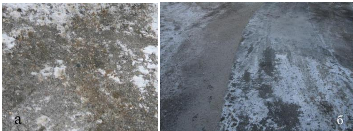
Рисунок 3.69 - Участок автомобильной дороги, покрытый льдом и СЛО, после прохода льдоскалывателя
