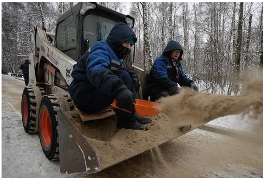
Рисунок 1.4 – Ручной способ распределения фрикционных материалов
