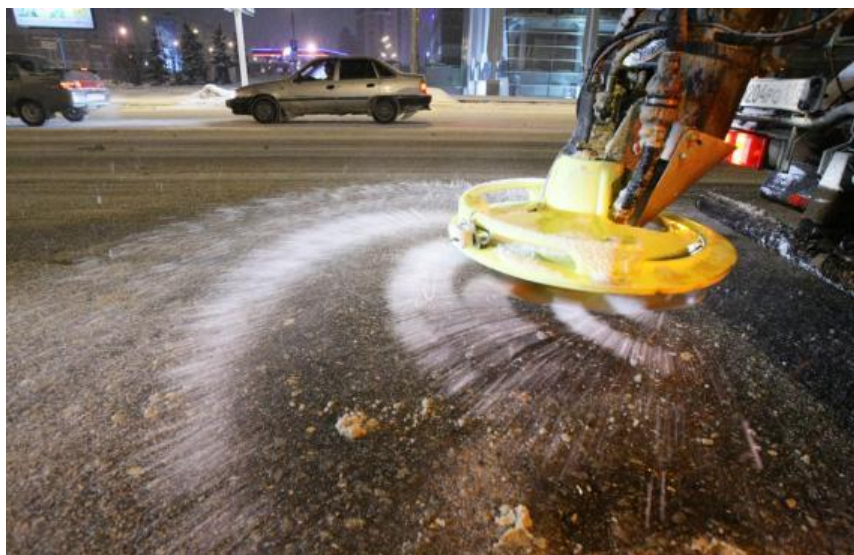
Рисунок 1.5 – Распределение на полотне дороги твердых реагентов
