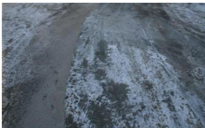
Рисунок 3.80 – Результат работы ударно-щеточного РО
